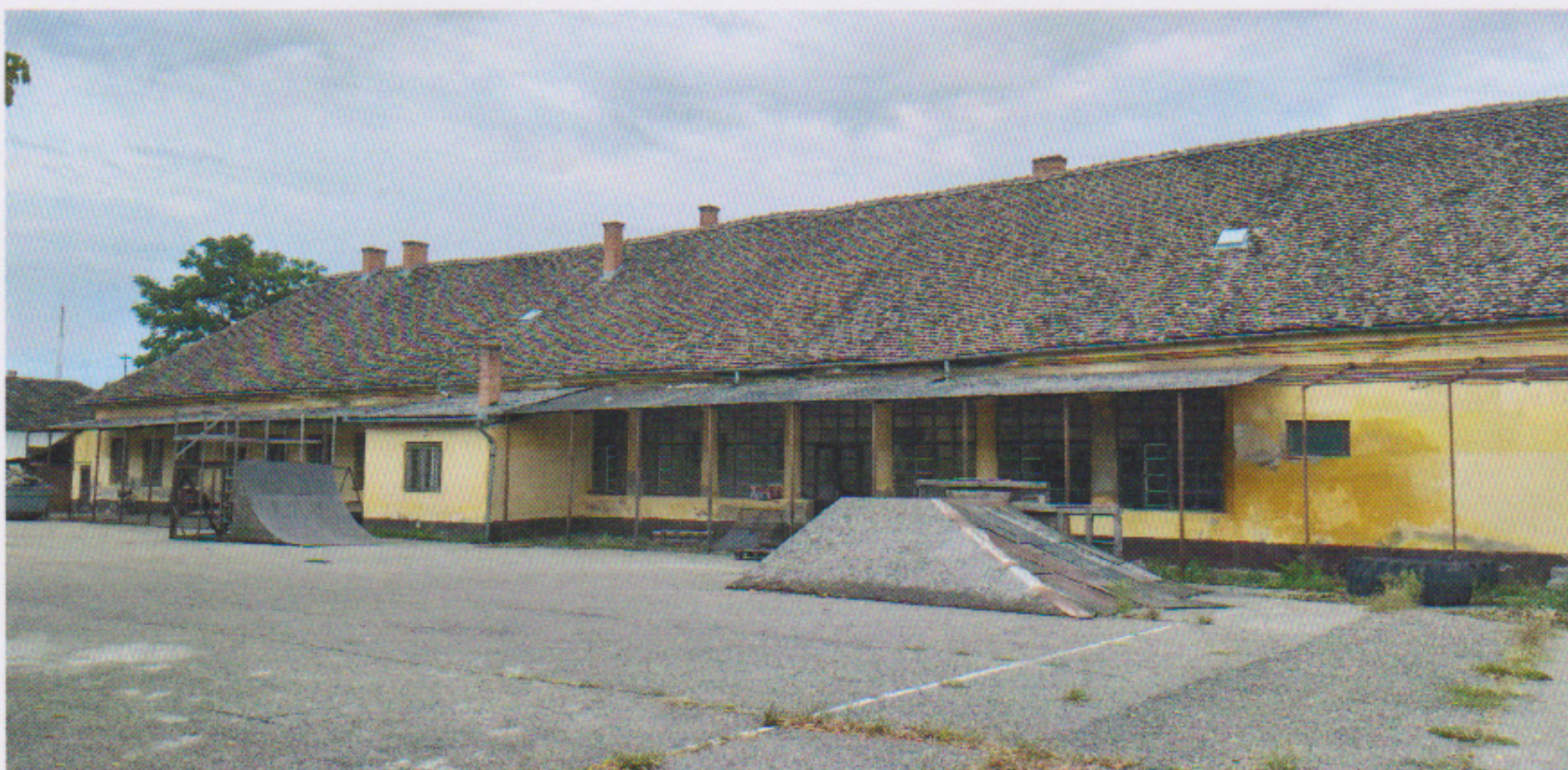
Az épület udvari homlokzata az utóbbi évtizedekben hozzáépített toldásokkal
