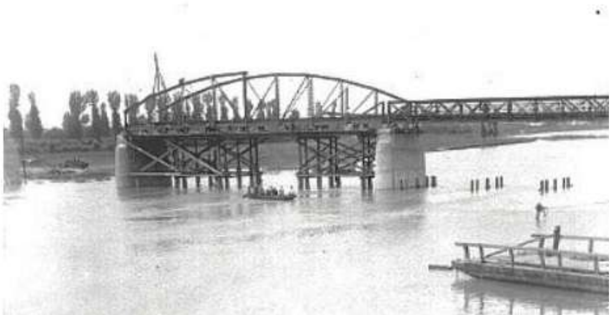
A híd építése
