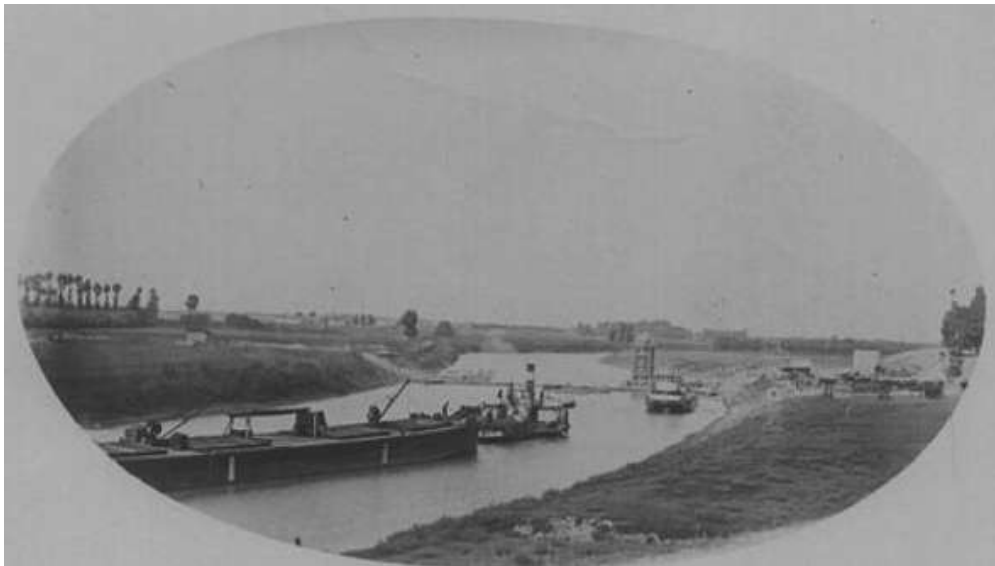
A híd építése
