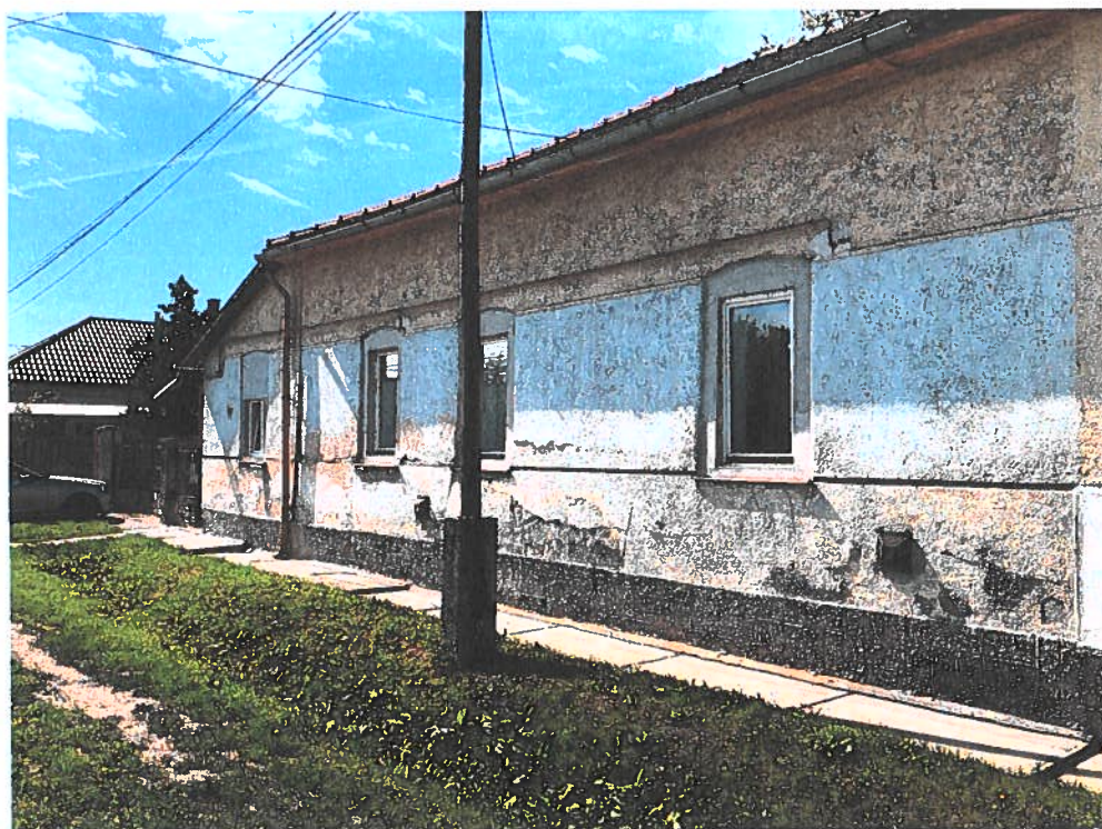
2. számú fotómelléklet (Az ingatlan Alkotmány utca felőli homlokzata)
