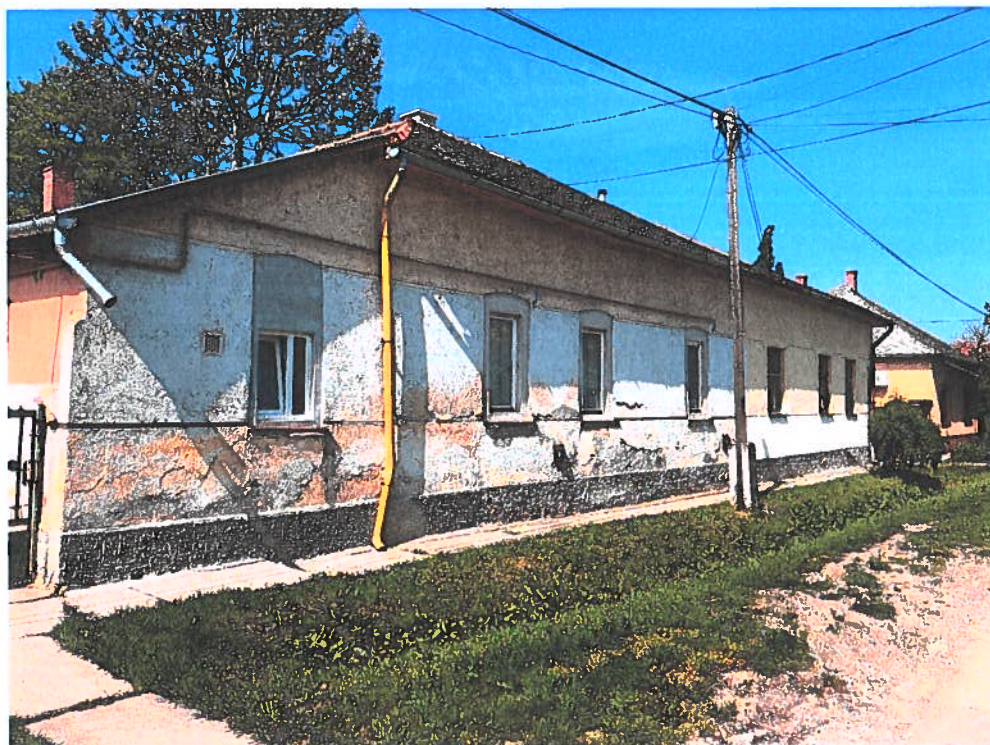
1. számú fotómelléklet (A négylakásos társasház Alkotmány utca felőli homlokzata)
