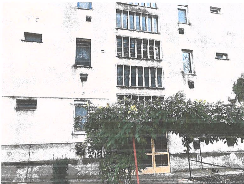
1. számú fotómelléklet (Társasház bejárat felőli külső homlokzata)
