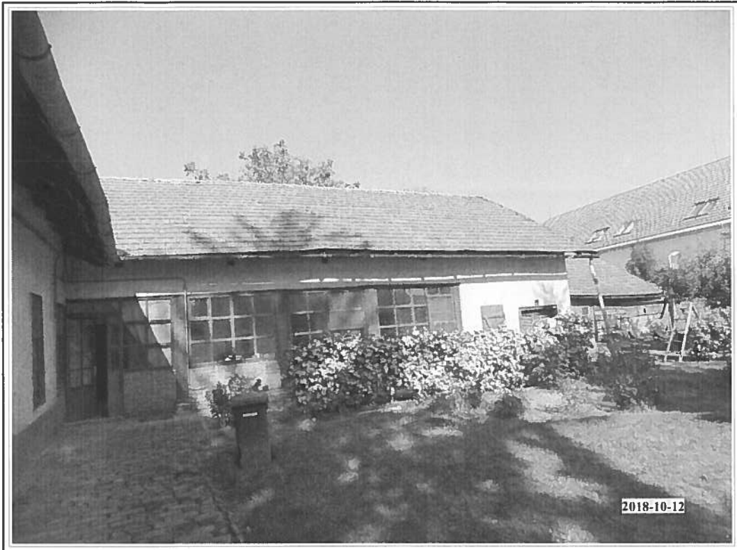
3.sz fotó: Lakóház udvari homlokzata
