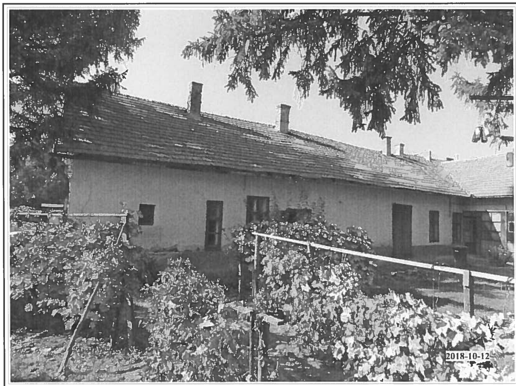
2.sz fotó: Lakóház udvari homlokzata
