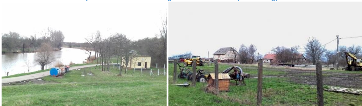
49. kép: A Csengedi holtág partja és vízfelülete, a Nagy-éri szivattyúház, valamint a helyi építészeti értéként védett Almásy uradalomhoz tartozó magtár és közvetlen környezete Kungyaluban
