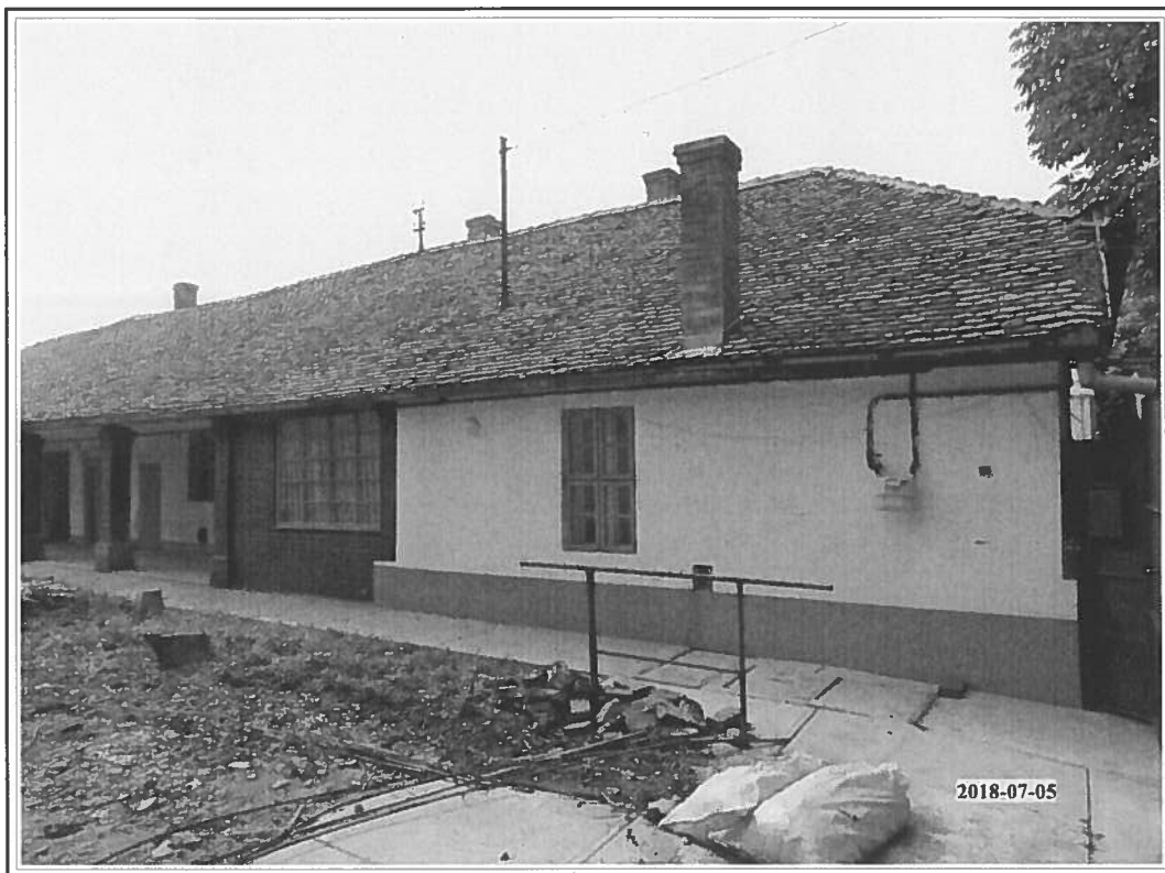
3.sz fotó: Lakóház udvari homlokzata
