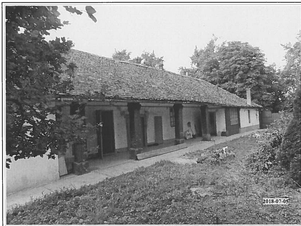
4.sz fotó: Lakóház udvari homlokzata
