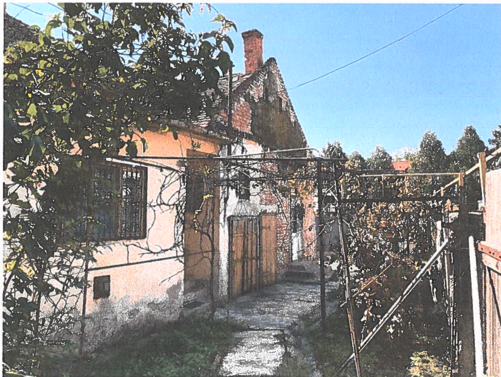
2. számú fotómelléklet (Az épület külső homlokzata)
