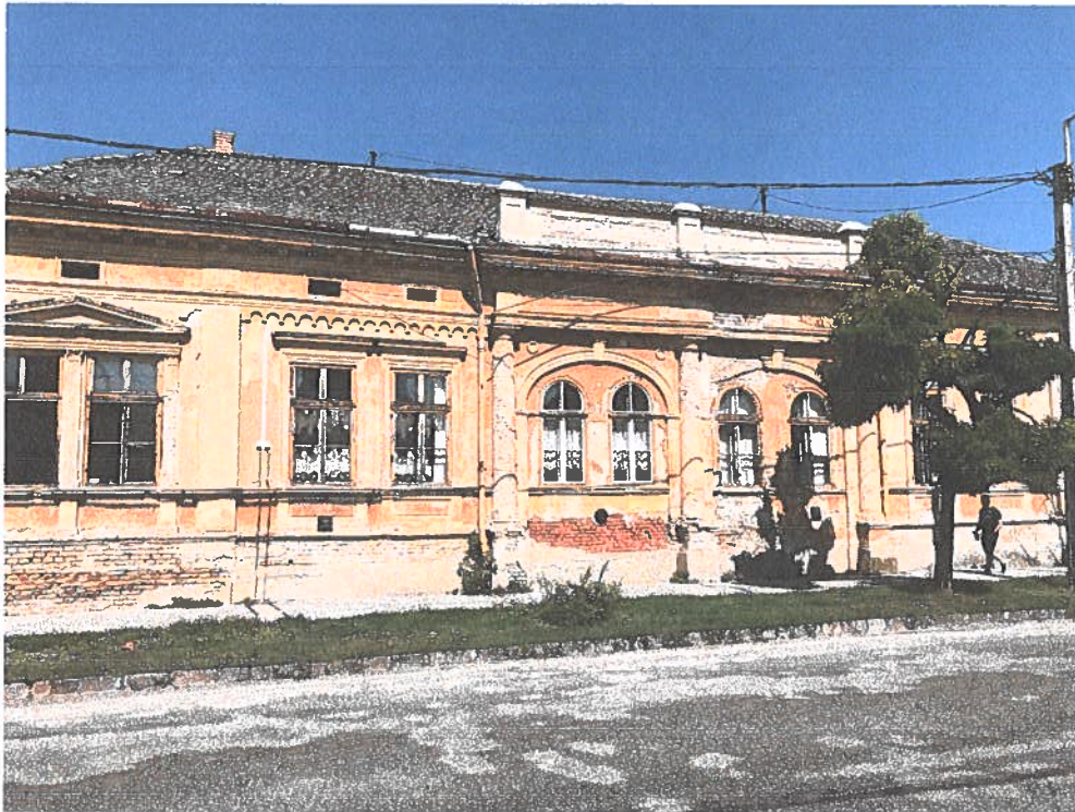
1. számú fotómelléklet (Az épület külső homlokzata)
