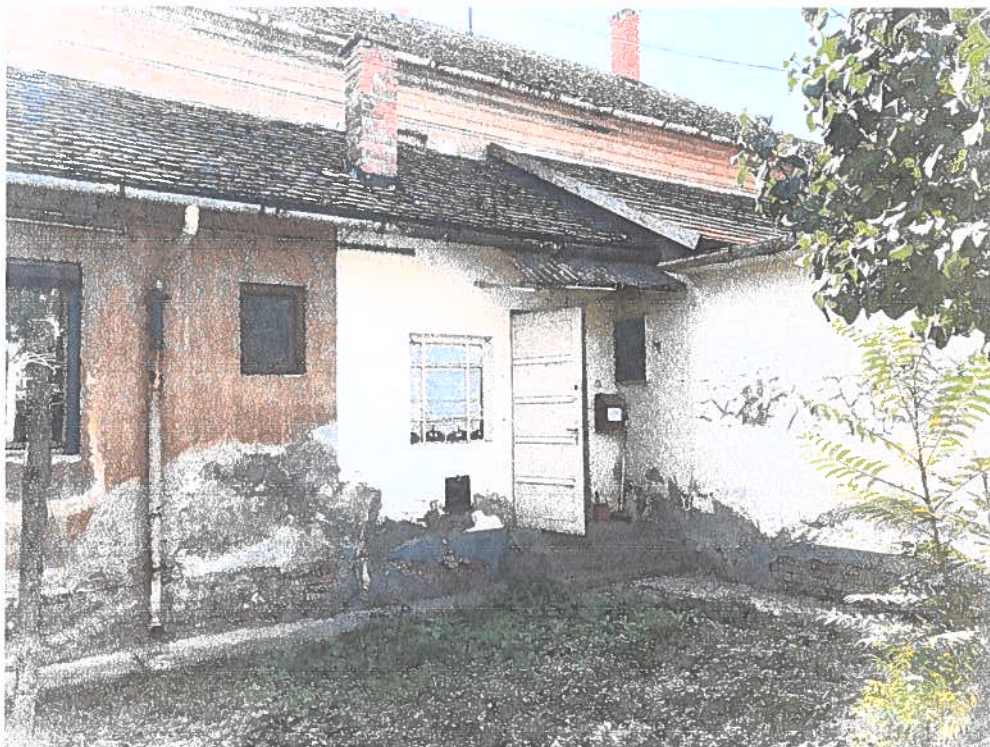
4. számú fotómelléklet (Az épület külső homlokzata)
