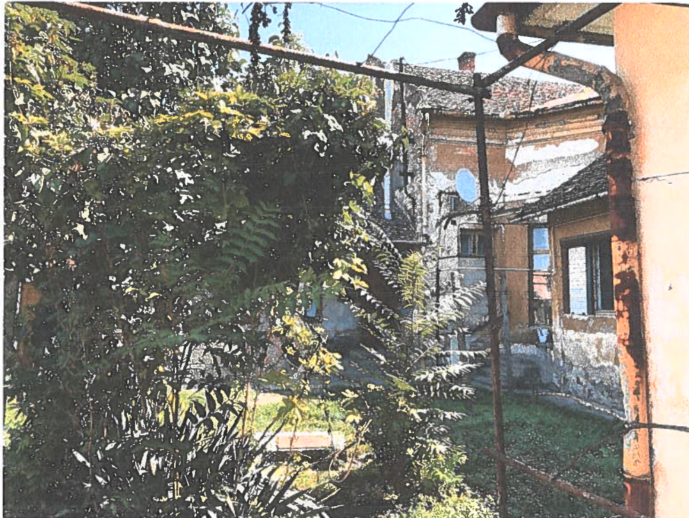
3. számú fotómelléklet (Az épület külső homlokzata)
