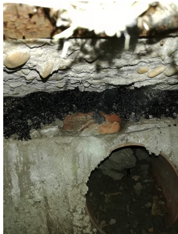
Bethlen G u. 6. szám sarki ingatlanánál lévő ülepítő fordító akna KG PVC anyagú bekötése a Bethlen G. utcai szikkasztók irányában, melynek másik vége a szikkasztóknál nem fellelhető, erősen eltömődve
