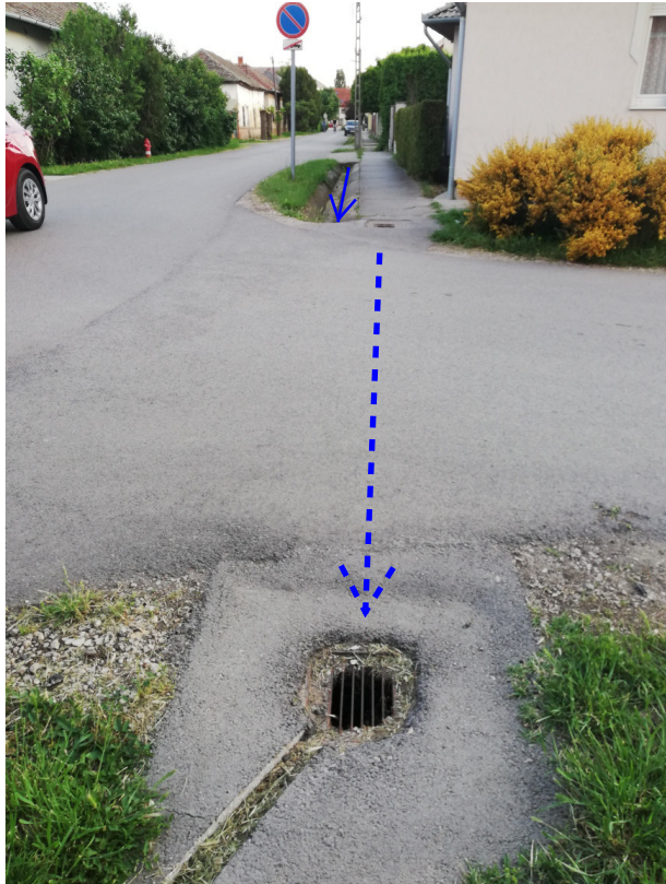
Meglévő ülepítő és ülepítő-fordító aknák a Bethlen G. u. útburkolat alatti átvezetésnél.
