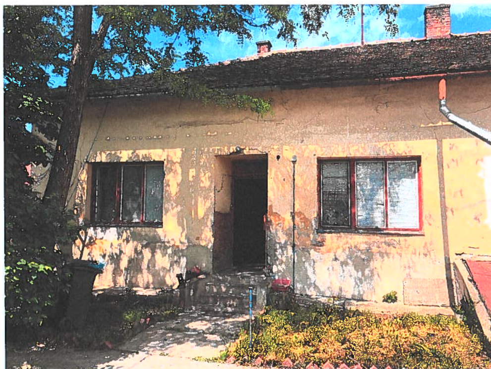
2. számú fotómelléklet (A vizsgált ingatlan udvar felőli homlokzata)
