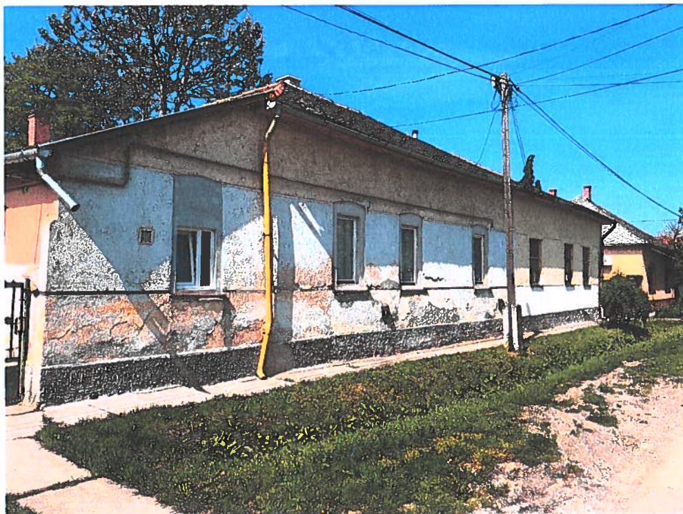
1. számú fotómelléklet (Az ingatlan Alkotmány utca felőli homlokzata)
