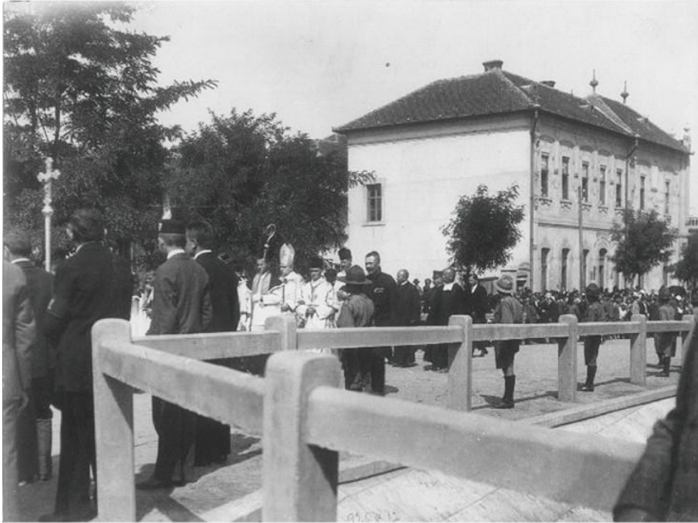
A híd felavatása 1925.
