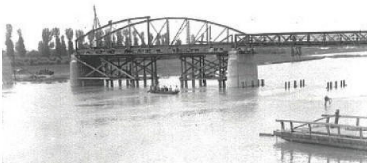
A híd építése
