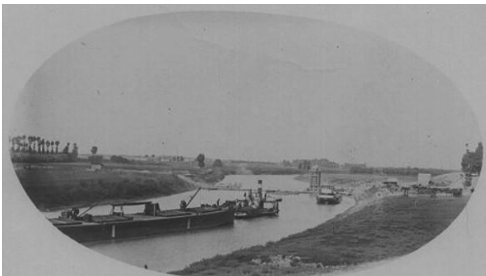
A híd építése
