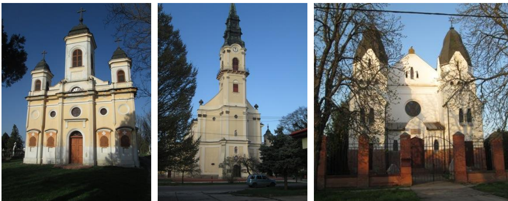
Felsővárosi Szentlélek kápolna, a Szent Márton Katolikus templom, a Zsinagóga épülete.
